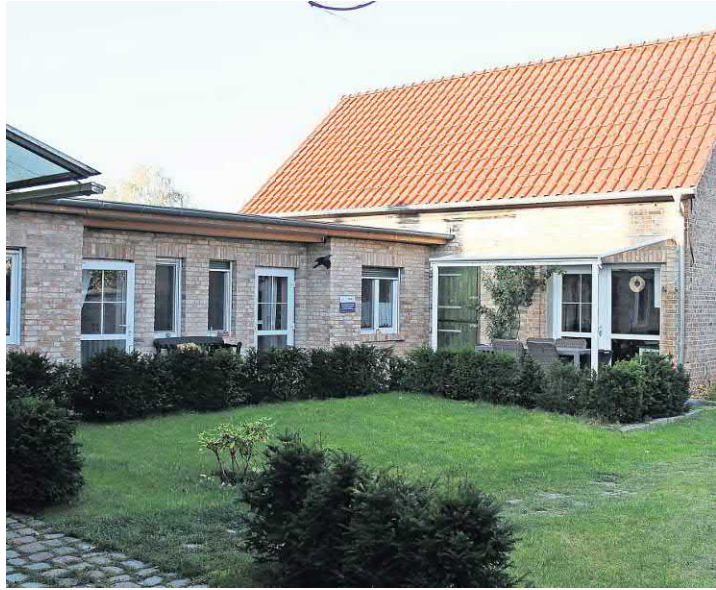
Das flache Gebäude ließ Gabriele Haubner neu bauen, dort befinden sich die Unterkünfte. Rechts: Gemeinschaftsküche.
