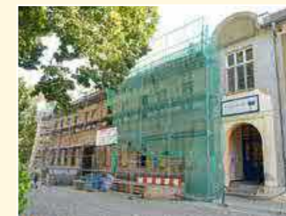
Das neue Schulzentrum am Kirchplatz im Entstehen
